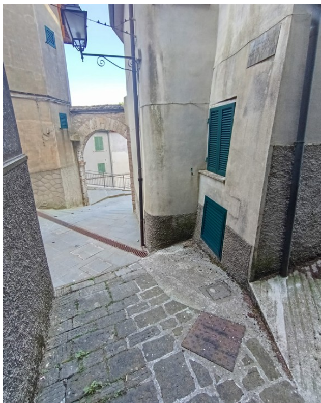
Fig. 3: Evidenza delle complessità cantieristiche
