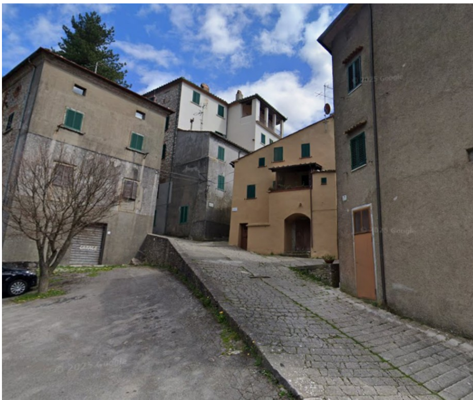
Fig. 2: Evidenza delle complessità cantieristiche
