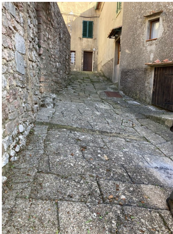
Fig. 7: Evidenza delle complessità cantieristiche
