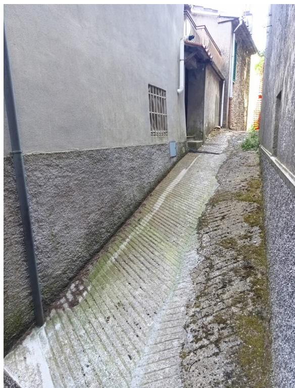
Fig. 5: Evidenza delle complessità cantieristiche
