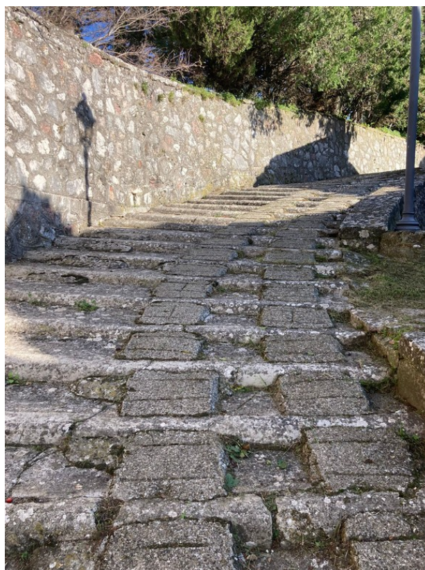
Fig. 6: Evidenza delle complessità cantieristiche
